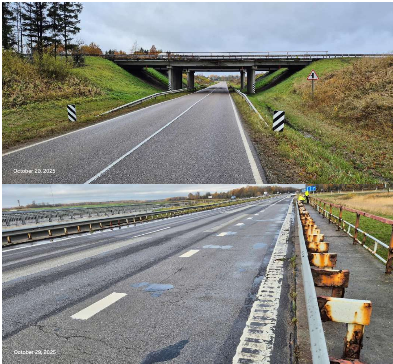
Pav. 2 Esamo viaduko vaizdas
