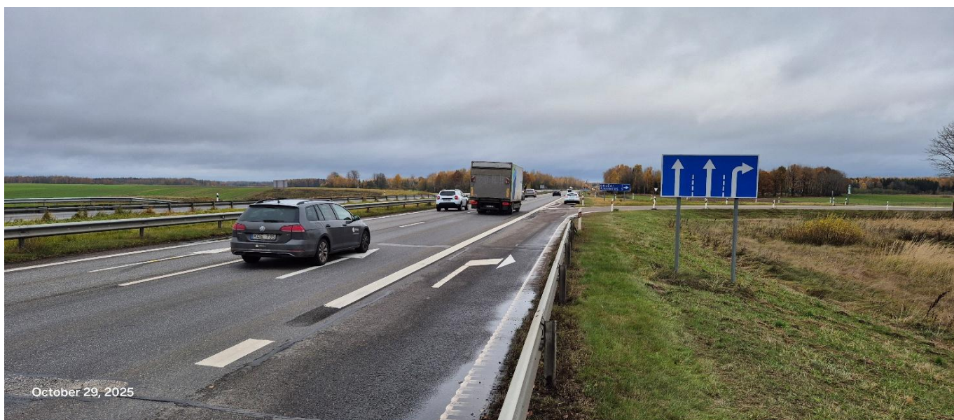
2 pav. Esama situacija už viaduko A2 Vilnius-Panevėžys
