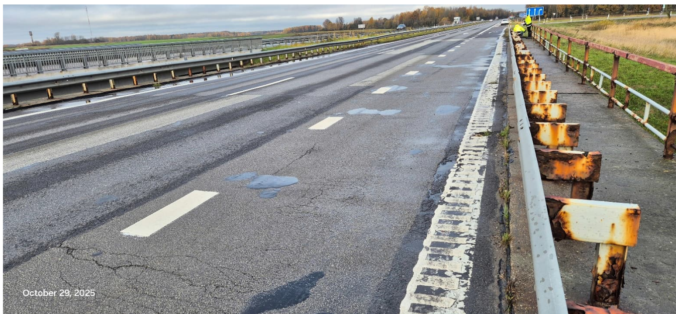
Pav. 2 Esamo viaduko vaizdas
