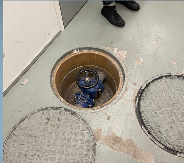
Pav. darbiniame režime SPKAS atjungiamo nuo visų inžinerinių tinklų: uždaroma kanalizacija, vandentiekis, ortakių angos uždaromos sprogimo bangai atspariais plieno lakštais – 15mm
