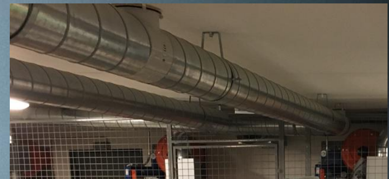
Pav. standus šviestuvų tvirtinimas Pav. standus ortakijų tvirtinimas
