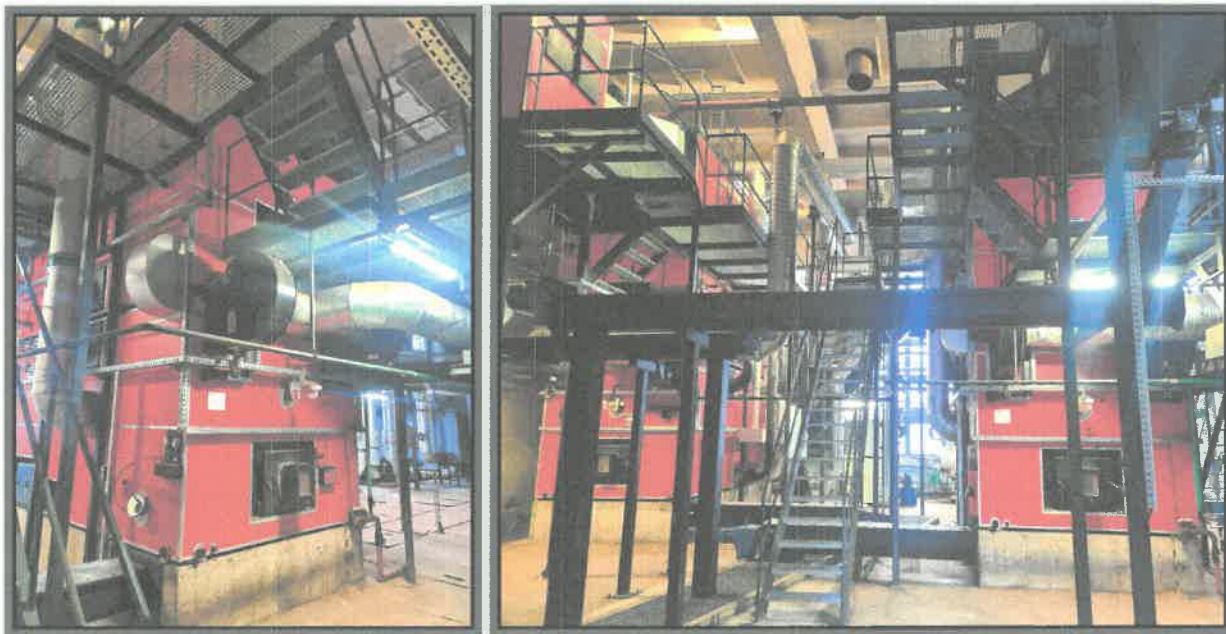
1 pav. Sumontuoti 3,1 MW ir 5 MW katilai
